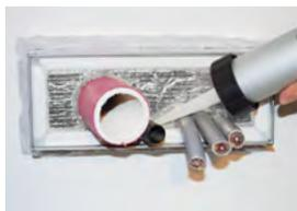
**10.** Danach werden alle Restöffnungen mit einem witterungsbeständigen dauerelastischen Dichtstoff, wie z.B. witterungsbeständiges Silikon, rauchdicht verschlossen.
