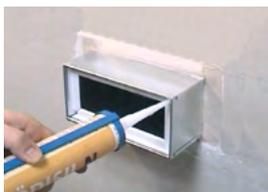
5. Als Reserveschott werden jetzt die EasyFoam – Stopfen eingesetzt und die Restöffnungen z.B. mit Silikon abgedichtet.
