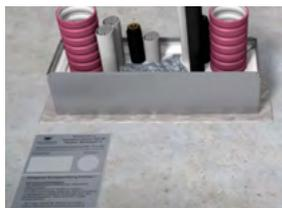
8. Nach der Installation wird das ausgefüllte Güteschild neben der Abschottung dauerhaft und gut sichtbar befestigt.
