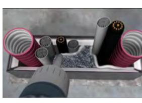
6. Danach werden alle Restöffnungen mit einem witterungsbeständigen dauerelastischen Dichtstoff, wie z.B. witterungsbeständiges Silikon, rauchdicht verschlossen.
