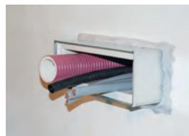
6. Es folgt die Kabelverlegung. Der Innenraum kann zu 100% genutzt werden. Bei großen Kabelmengen ggf. vorher schon Zwickel abdichten.
