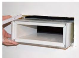
2. Box waagrecht in die Öffnung einsetzen, dass auf keiner Seite mehr als 8,5 cm aus der Wand stehen.
