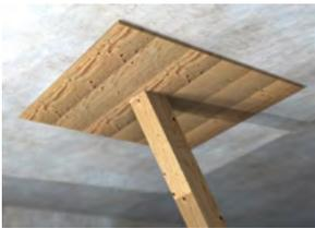
1. Als erstes montieren Sie ein Schalbrett unter der Deckenöffnung.
