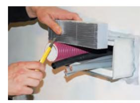
4. Nach der Kabelinstallation werden die EasyFoam-Stopfen einige mm größer als benötigt zugeschnitten, damit sie hinterher fest in der Öffnung sitzen.
